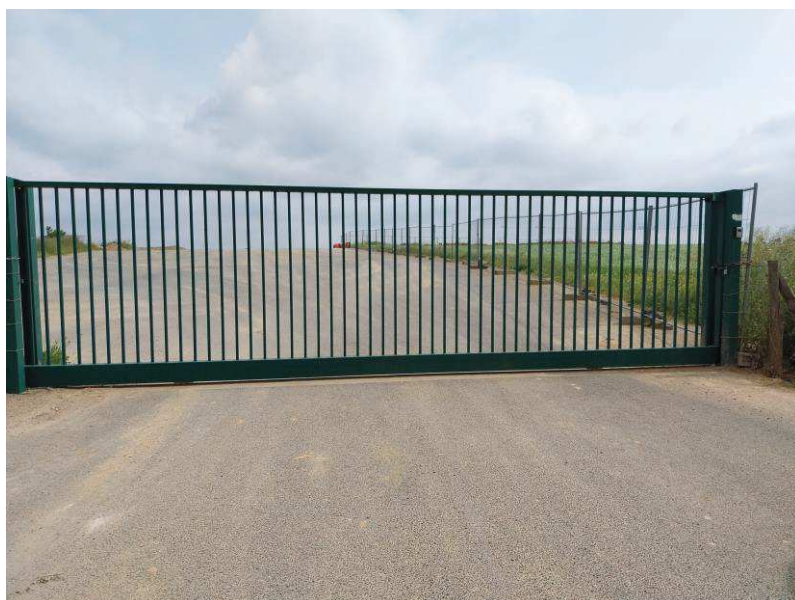
Figure 22 : Portail fermant l'accès au site
